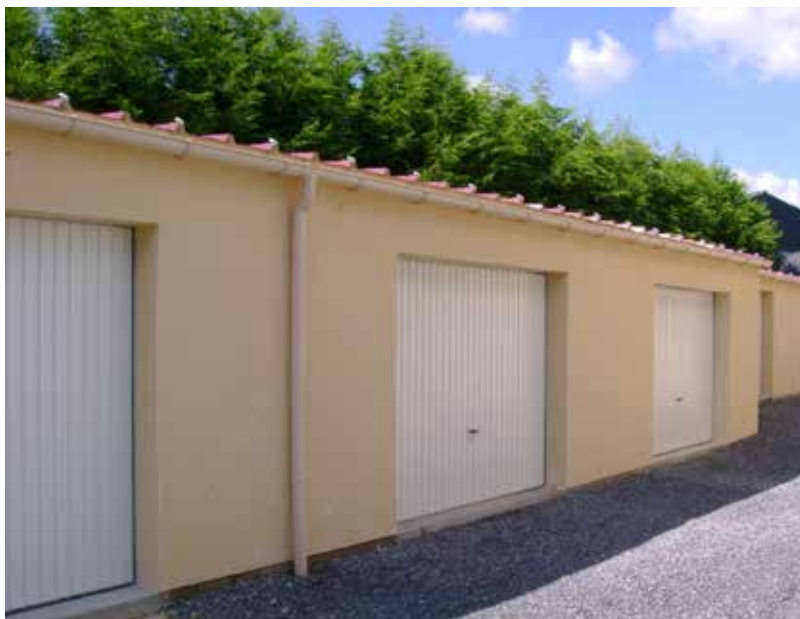
Les bâtiments annexes (à côté de du hangar municipal).
