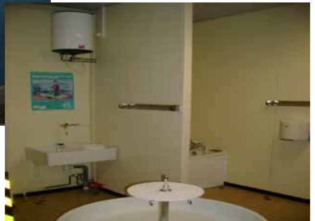
Un ballon d'eau chaude pour alimenter les colonnes lavabos de l'école maternelle
