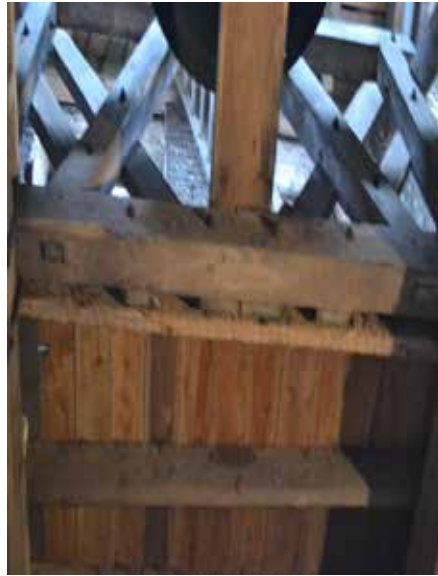
Le plancher du clocher réalisé par les services techniques
