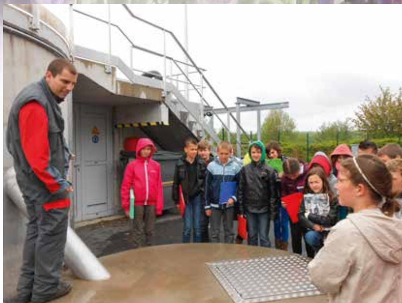
Visite de la station d'épuration de Lewarde.
