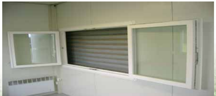
Installation d'une fenêtre en PVC pour la buvette du bungalow au stade
