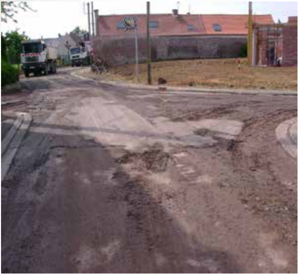
La réfection complète de la chaussée de la rue du Mont.
