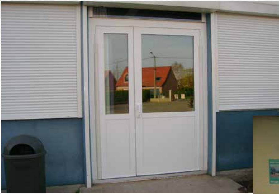
Pose d'une porte de secours alu à l'école (côté primaire) « CP »
