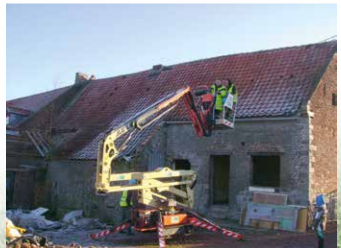
Déconstruction de la Maison Poulain
