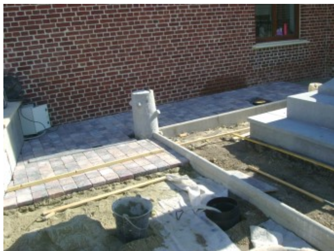
Pose des bordures et du pavage
